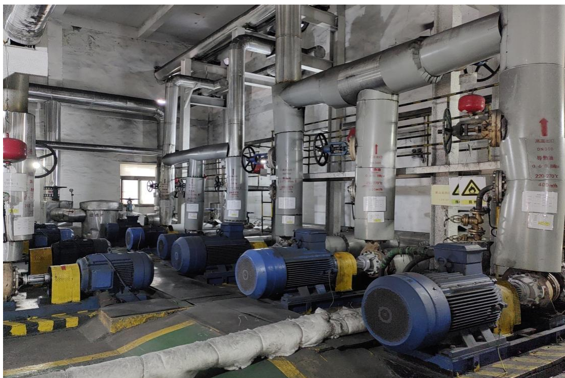
移动式真空抽提装置运行现场
